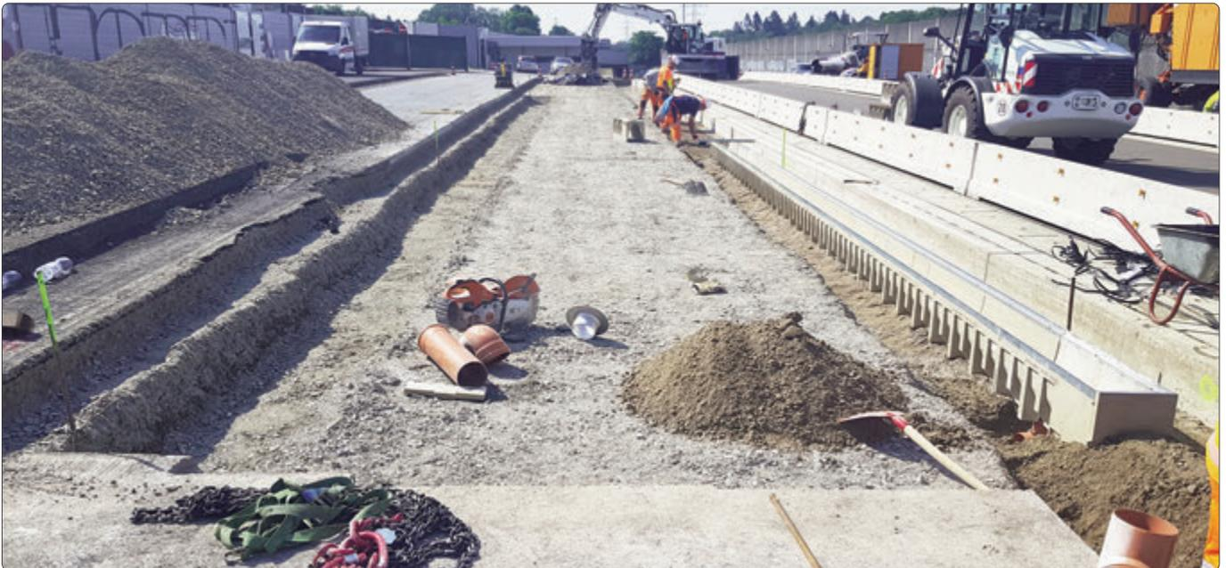
Einbau der Temperierten Straße auf dem duraBAST – Abtragung der vorhandenen Fahrbahn und Einbau der Rinnen
