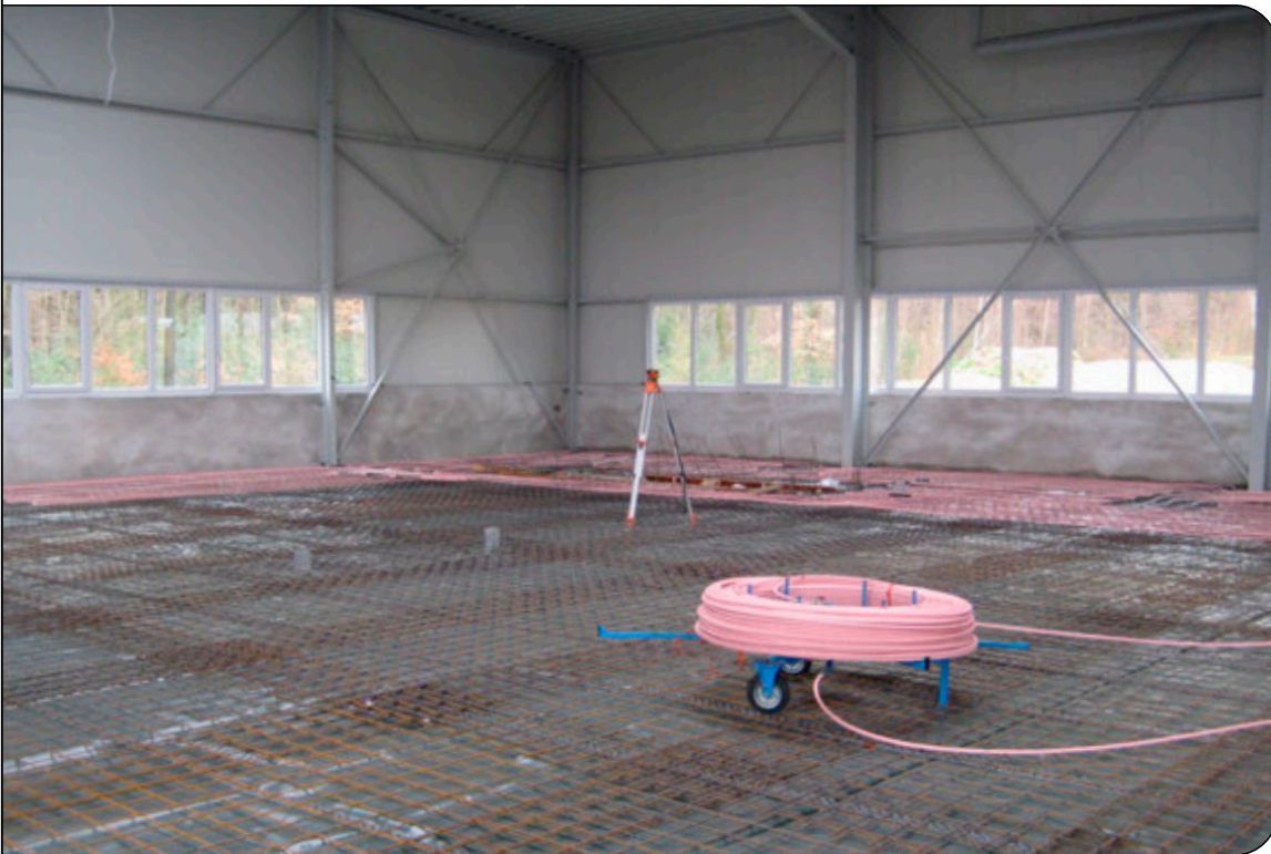
Produktionshalle während der Verlegung...
