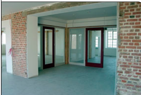
nach der Estrichverlegung
