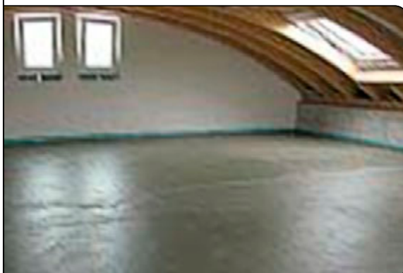
mit fertig verlegtem Estrich
