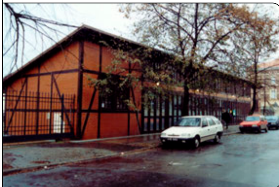
große Fensterflächen im Fachwerk
