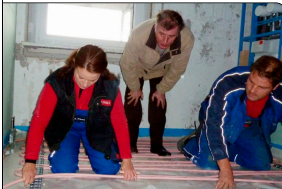
Verlegung der MB-Fußbodenheizung
