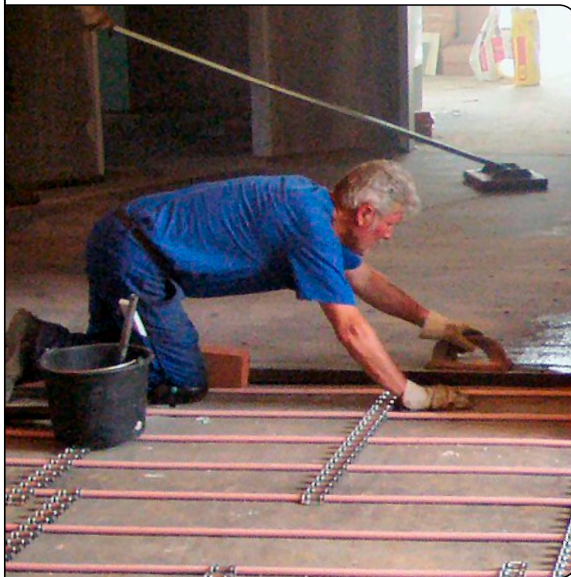
Verlegung des Gussasphalts
