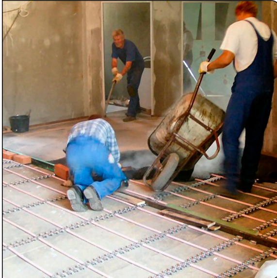
Einbringung des Gussasphalts auf das MB-System
