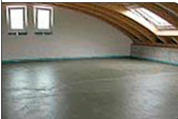
mit fertig verlegtem Estrich
