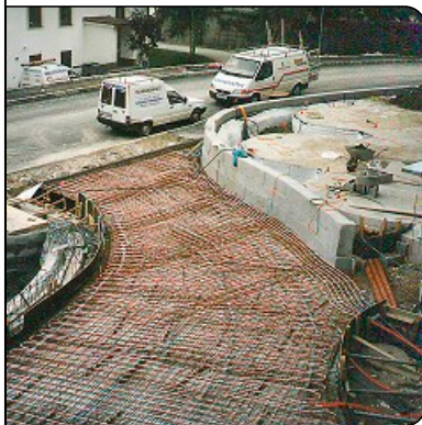
Heizrohrverlegung
