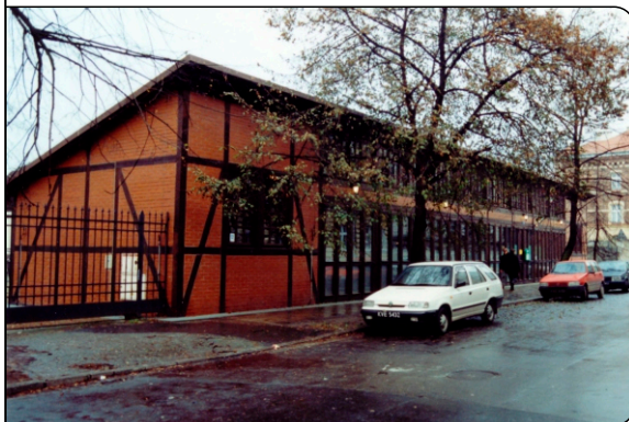
große Fensterflächen im Fachwerk
