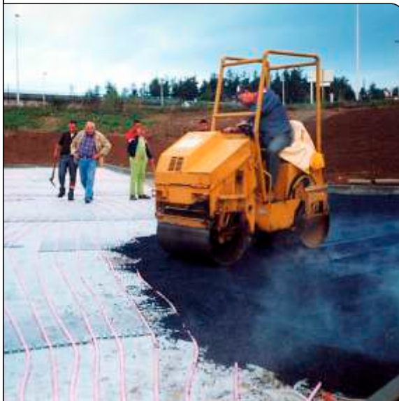
Verlegung des Walzasphalts
