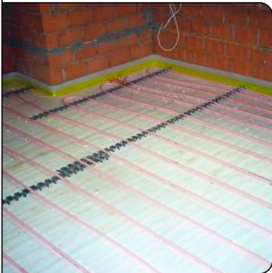
verlegtes MB-Estrichsystem
