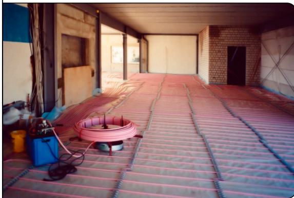
Verlegung der Fußbodenheizung
