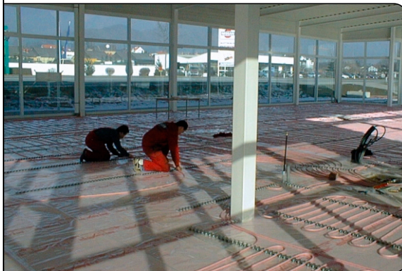
Verlegung der Fußbodenheizung
