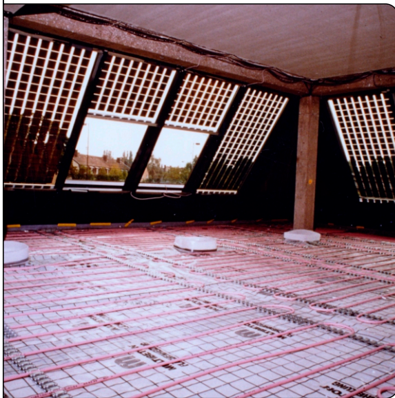
MB-System im Geschäftsführerbüro
